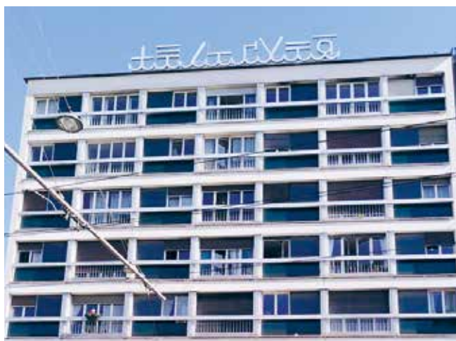
L'immeuble du 20, avenue Henri-Dunant et son enseigne en caractères « martiens »
